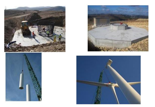
Fotografias 4.1 a 4.4 – Aspectos da construção de uma Central Eléctrica Eólica
